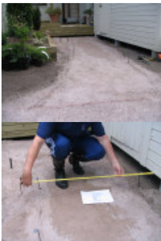
Tee kiveyksen pohjatyöt huolellisesti. Mittaa ja merkitse asennettavan kiveyksen ulko-reunat.
