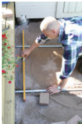
Käytä esim. metalliputkia ohjureina pohjan tasaamisessa. Käytä vatupassia apuna.
