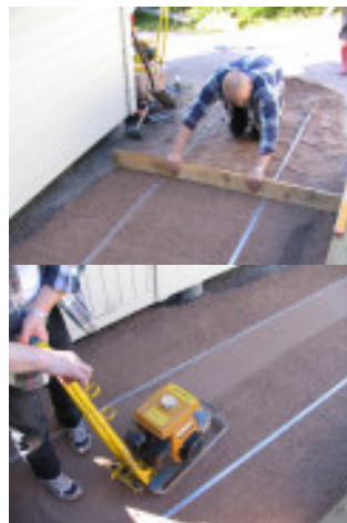
Lisää kivituhkaa niin, että pohja on tasainen. Tiivistä huolellisesti.
